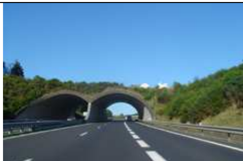
La région pilote de l'Isère s'apprête à construire un pont vert.
